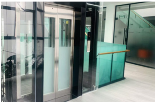
垂直电梯可直达二楼和三楼办公区
